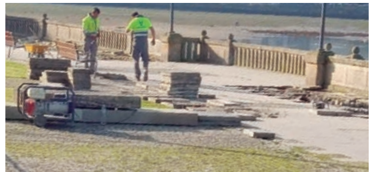
Obras de arranxo do paseo marítimo
