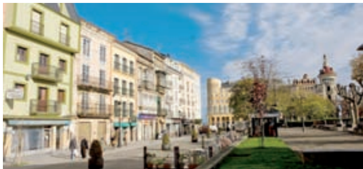
Vista da zona ARI de Ribadeo
