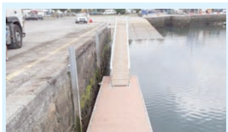
NOVO PANTALÁN EN VIVEIRO. Portos de Galicia vén de instalar un novo pantalán no porto de Viveiro para dar servizo á actividade de pasaxe. Dita instalación entrará en servizo esta mesma tarde e será empregada de xeito inmediato pola empresa concesionaria do transporte de pasaxeiros que opera nesta dársena lucense.
