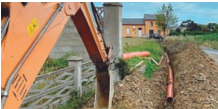
Unha vista das obras de saneamento en Cinxe
