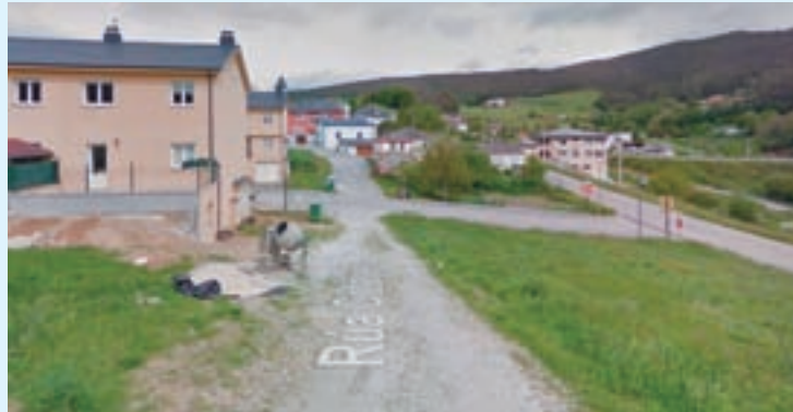
Vista da rúa Cotarelo
