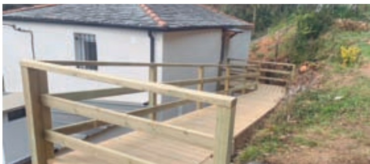
Pasarela de acceso ao centro social
