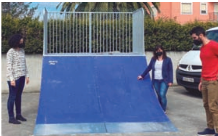
A alcaldesa, supervisando as obras da pista de skate
