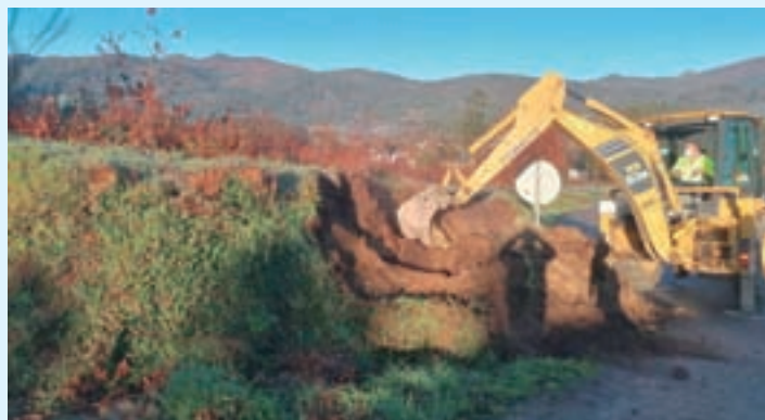
Un momento dos traballos de retirada do talude en Santa Cruz
