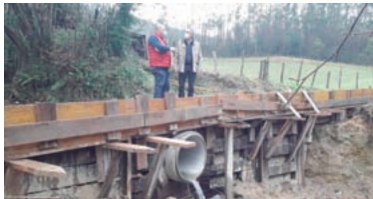
O alcalde e o director de Administración Local, visitando as obras
