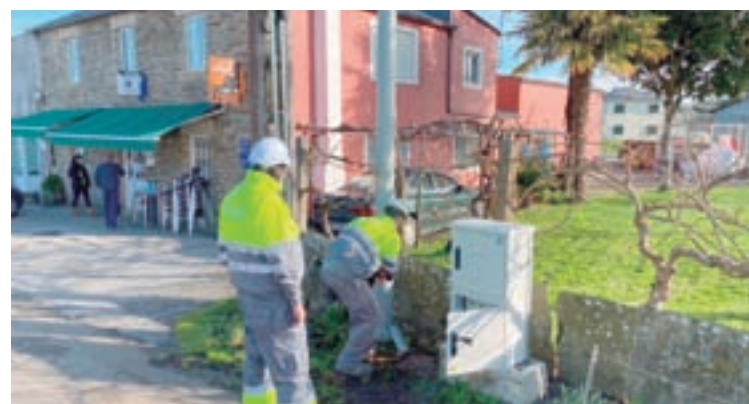
Instalación de luminarias
