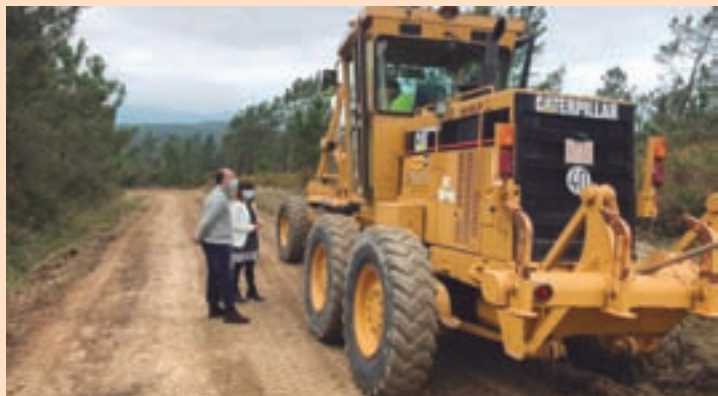
Visita ás obras da subida a Penabo
