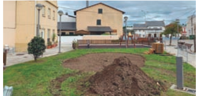
Estado no que se atopan as obras
