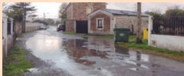
Unha imaxe do estado da vía na rúa Río de Amalló
