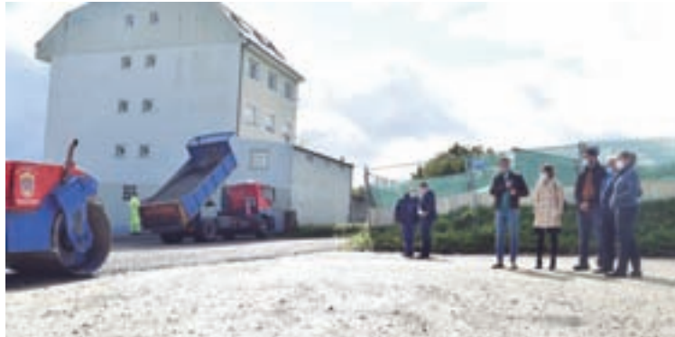
Visita do presidente da Deputación ás distintas obras que se realizan
